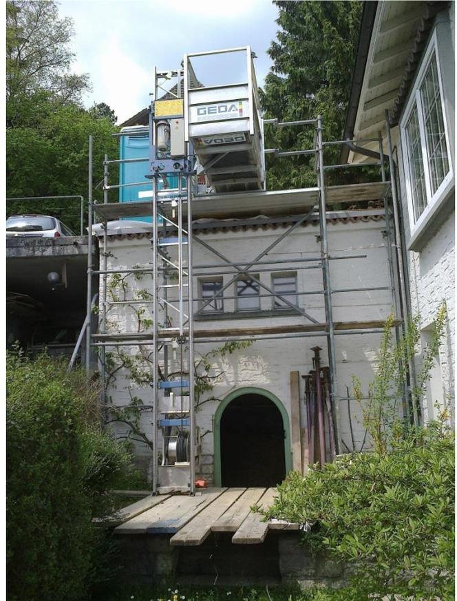
Unverzichtbar bei kleinen und mittleren Baustellen wie Sanierungen, Innenausbauten, Dachsanierungen usw. Praktisch ist, dass man mit einer Schubkarre direkt hinein fahren kann. Handlich mit zwei Personen zu montieren und auf kleinstem Raum zu benutzen.
