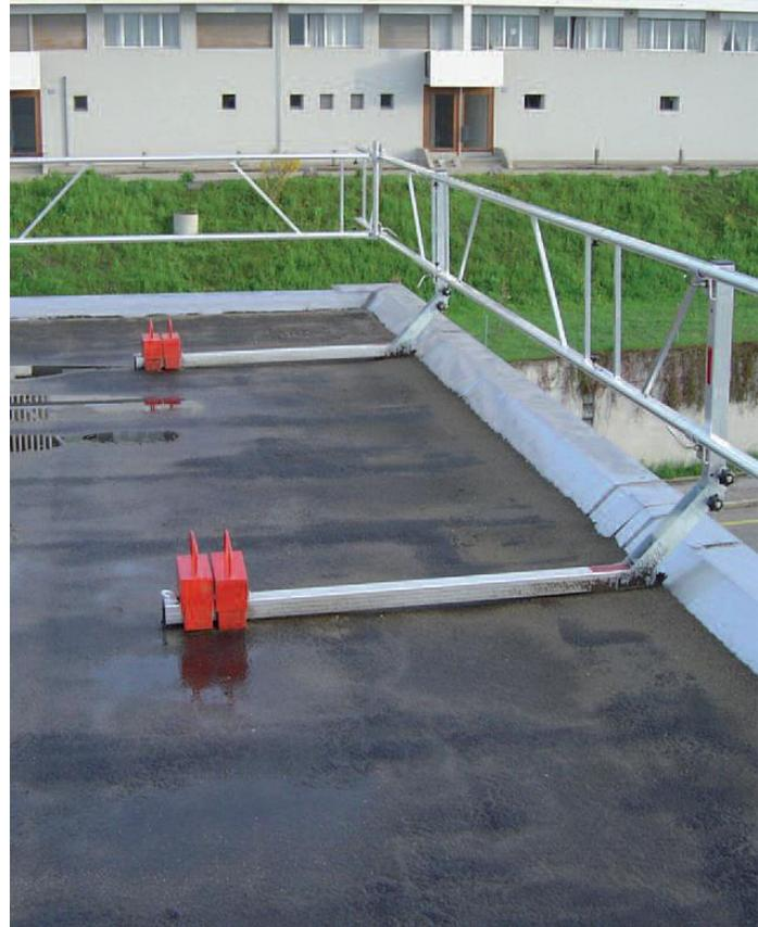
Ideales System als Absturzsicherung für Flachdachsaniierungen, Begrünungsarbeiten sowie Reparaturarbeiten aller Art. Die Stützelemente sind einzeln aufklappbar und ermöglichen somit ein uneingeschränktes und effizientes Arbeiten.
