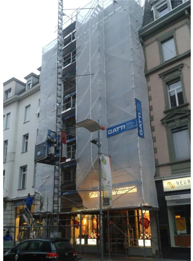
Die ideale Aufzugslösung auf Grossbaustellen bei Dachsanierungen, Fenstermontagen, Innenausbauten usw. Es können z.B. ganze Isolationspakete, Steinpaletten oder Fensterböcke samt Hubwagen ohne grossen Aufwand in jede gewünschte Höhe befördert werden.
